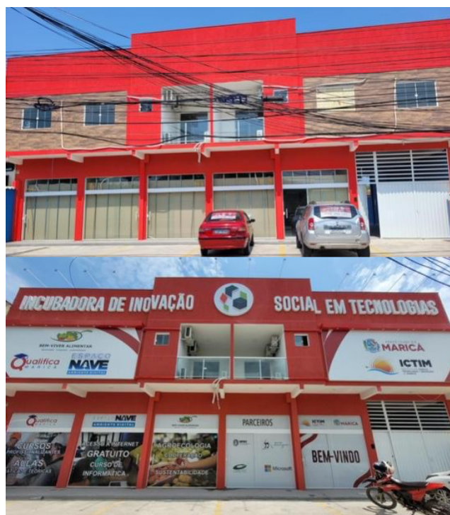
Figura 1 - Fotografia do prédio da IIST, antes e depois da finalização da fachada.
